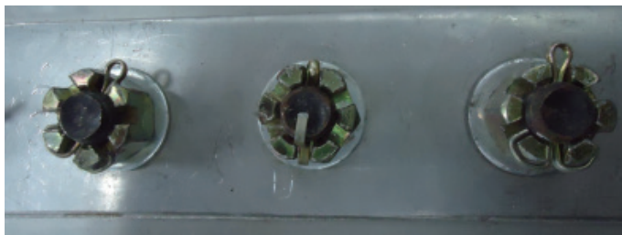
图 4-9-1 标准头型螺栓紧固件的开口销保险实物图
